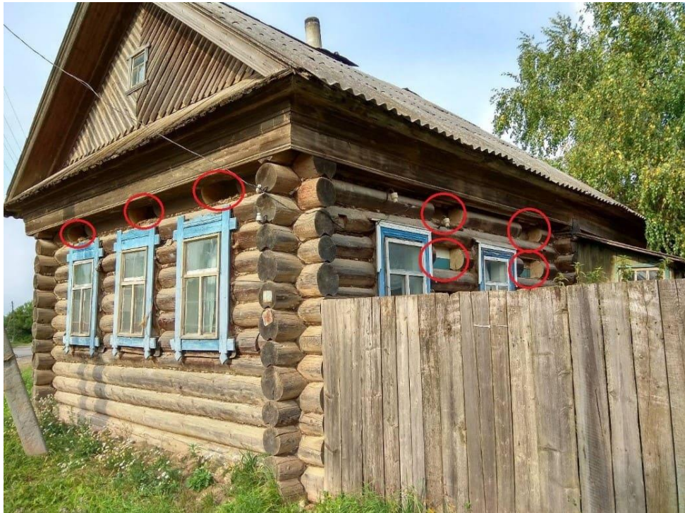
Рисунок 3.1 — Места отбора чурakov для изготовления опытных образцов
