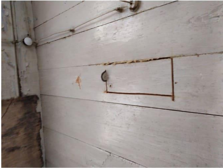
Рисунок 3.6— Процесс выпиливания пластин из потолочной доски
