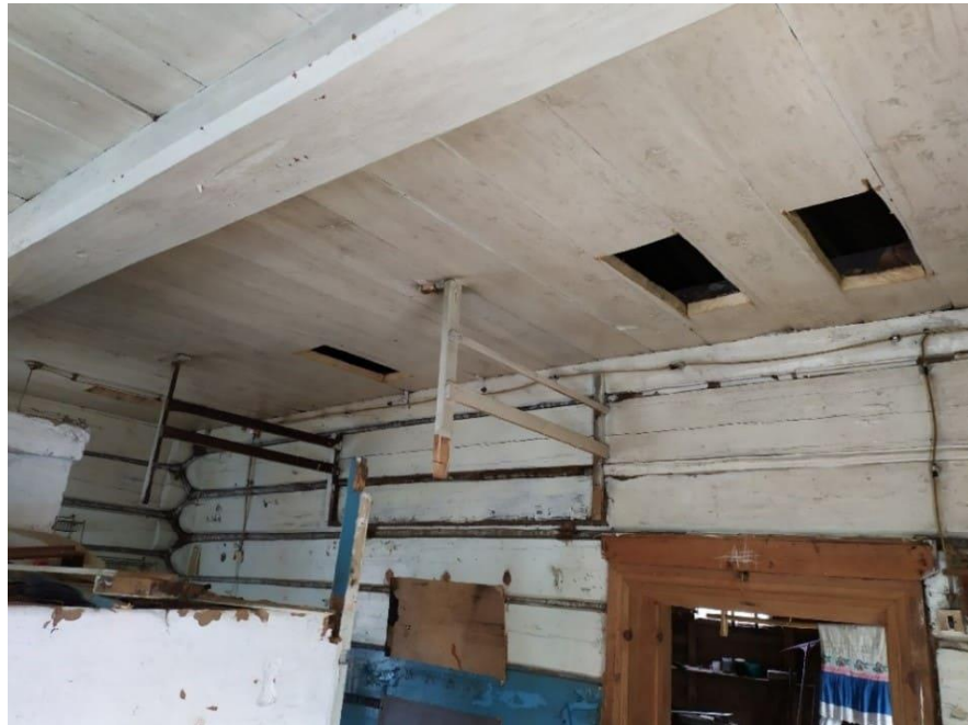
Рисунок 3.7— Места вырезки пластин из полочных досок
